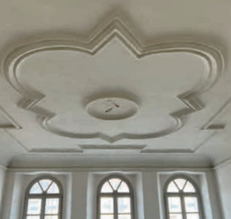
Il restauro di una delle sale interne di Palazzo a Prato, nuova sede della Fondazione Cassa Rurale Alta Valsugana
